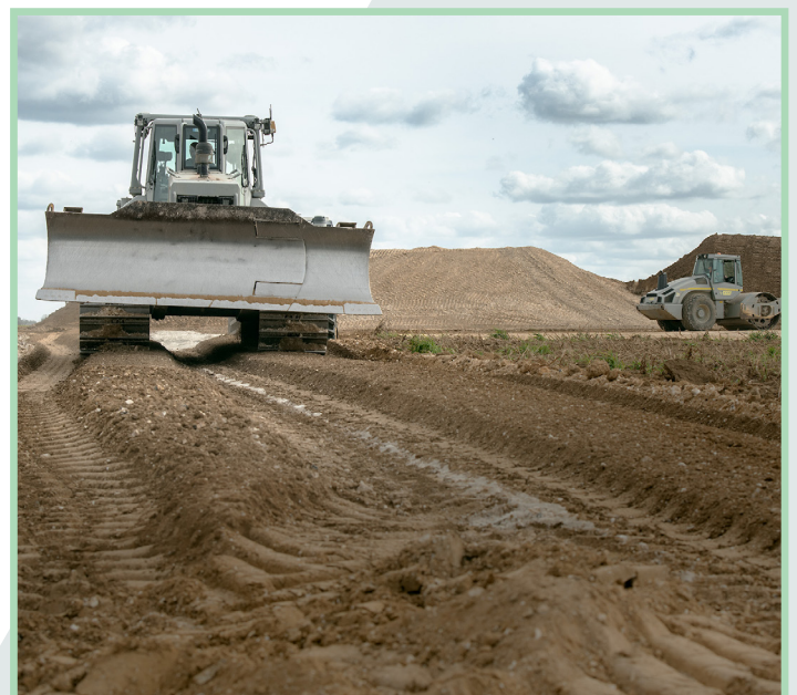
Aire de grutage en cours d'aménagement - 2023 © Alterric
