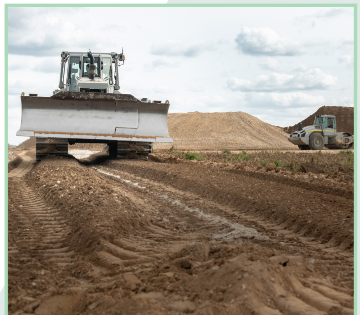
Aire de grutage en cours d'aménagement - 2023 © Alterric
