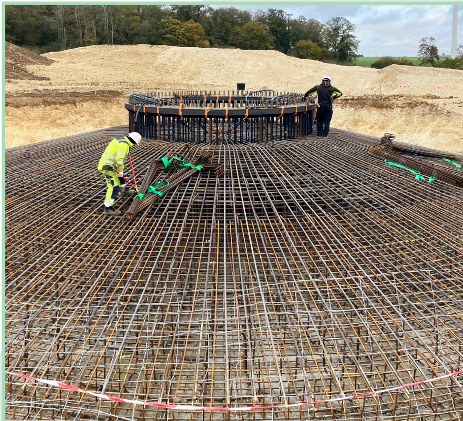
Fondation en cours de ferrillage - 2023 © Alterric
