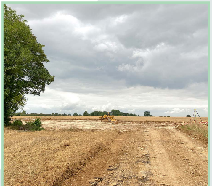
Aire de grutage en cours d'aménagement - 2023 © Alterric
