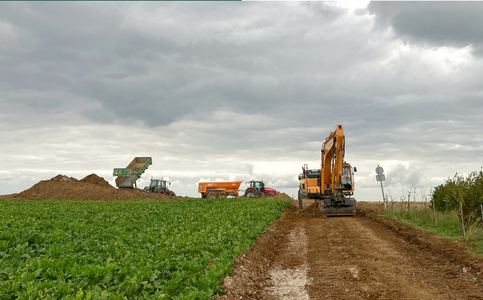
Chemins d'accès et aire de grutage en cours d'aménagement - 2023 © Alterric
